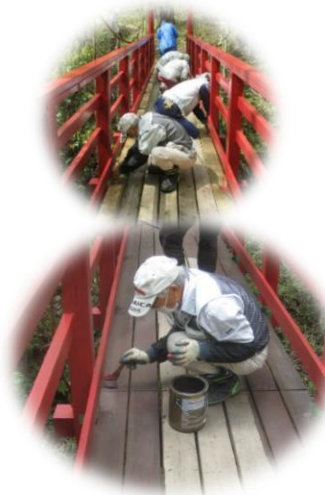
22 (R4) 04.22 床板の塗装 約 2 年かけ木橋の補修完成
